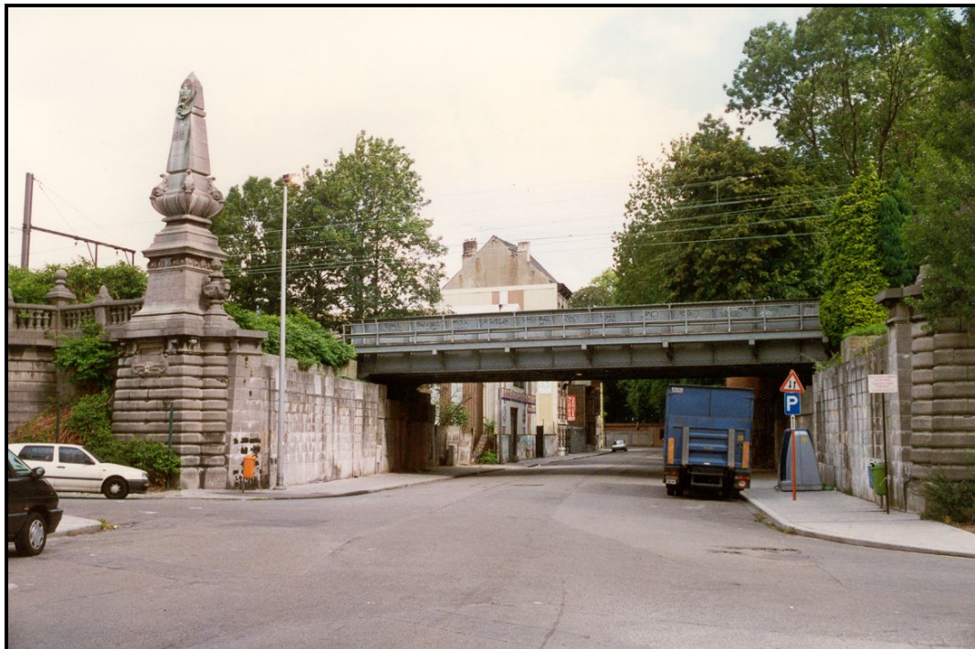
Illustratie 4: Kruispunt Paleizenstraat en Albertstraat. De oude spoorwegbrug is vervangen door een nieuwe brug, juist achter of naast de oude. De oude brug ziet men duidelijk op illustratie 10
